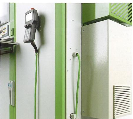
Biesse stattet die Schaltschränke serienmäßig mit Klimatisatoren aus, um auch bei hohen Raumtemperaturen die perfekte Funktion der elektronischen Komponenten zu gewährleisten. Der Klimatisator sorgt außerdem für optimalen Schutz gegen Staub, da die Kabine keinerlei Lüfterräder enthält.
