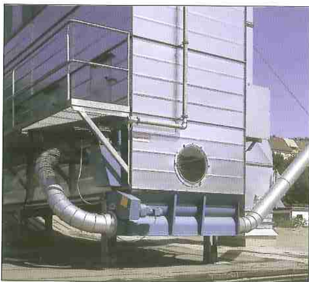
Kompaktfilter Längsbaureihe mit seitlicher Wartungsbühne
