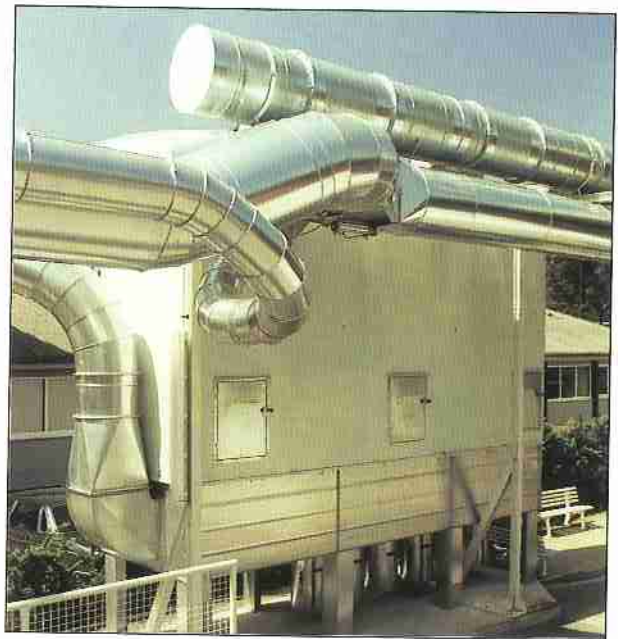
PGSQ mit Isolierverkleidung und Absackvorrichtung
