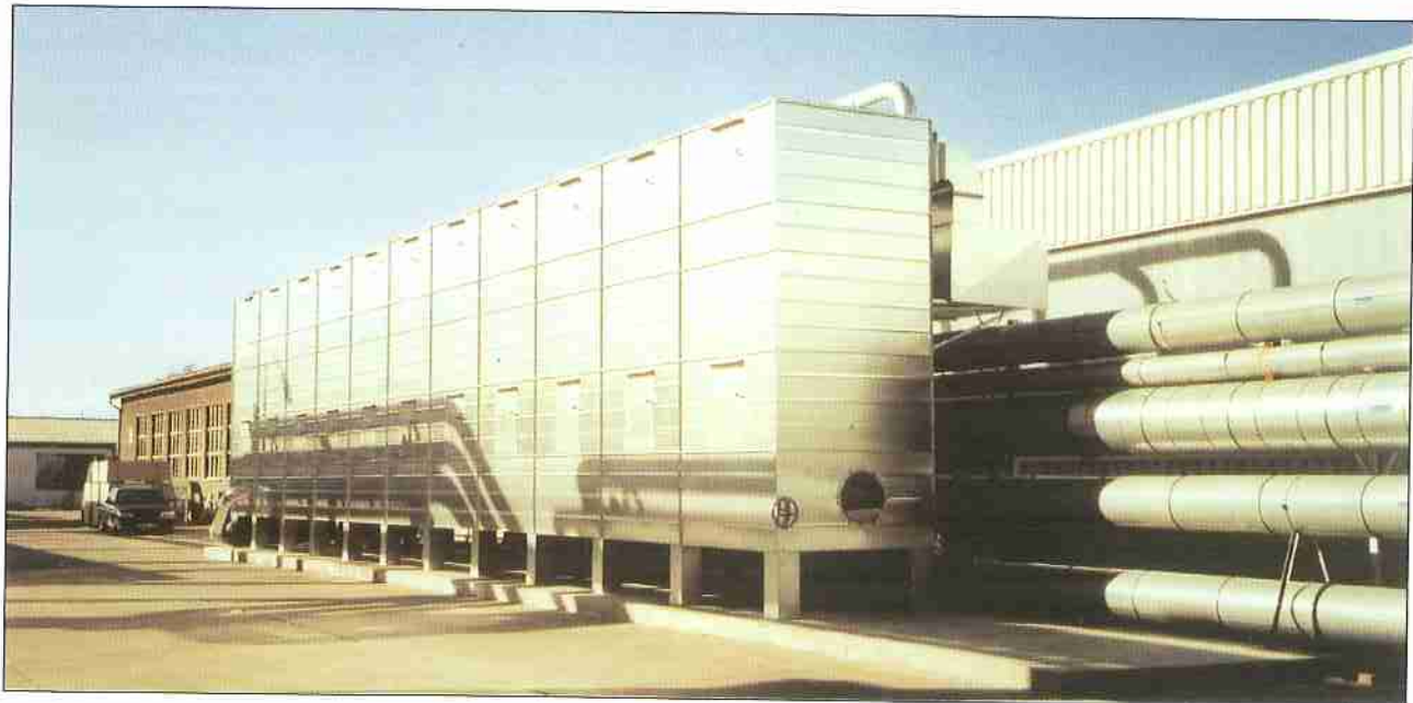
Reihenfilter für kontinuierlichen Betrieb mit Spülluftabreinigung 1.100 m 2 Filterfläche
