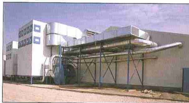
Rückluftkanalsystem mit Umlenkung und Druckentlastungsflächen
