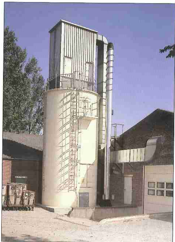
Deckenfilter, Typ PDF mit erhöhtem Einblasraum und Alutrapezverkleidung
