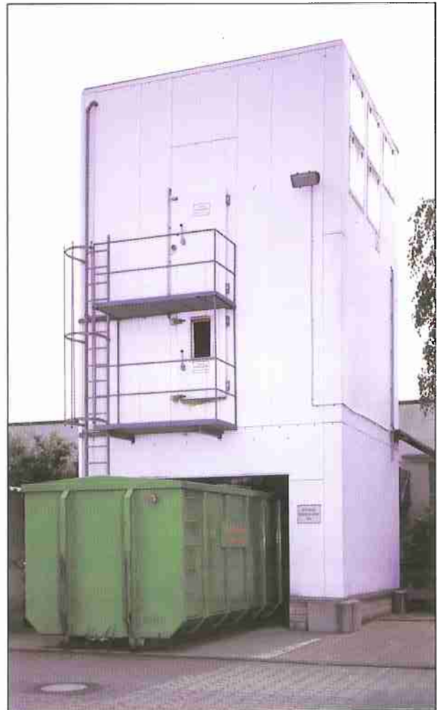
Filterhaus, Typ PFHA mit oberer und unterer Isolierverkleidung
