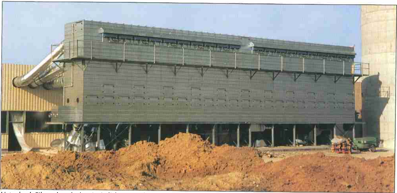
Unterdruck-Filteranlage für kontinuierlichen Betrieb, 2.240 m 2 Filterfläche
