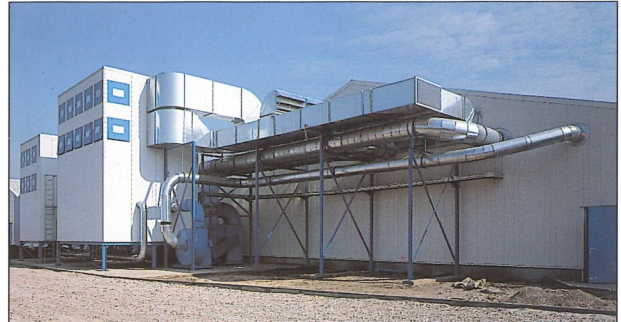
Rückluftkanalsystem mit Umlenkung und Druckentlastungsflächen
