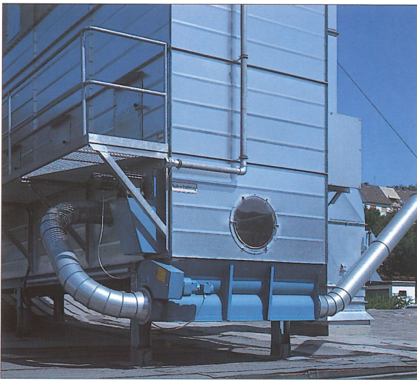
Kompaktfilter Längsbaureihe mit seitlicher Wartungsbühne
