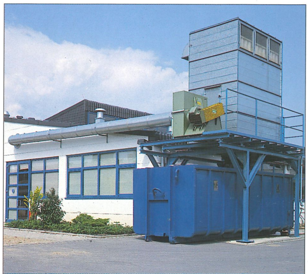
Kompaktfilter PKFQ mit Containerbeschickung
