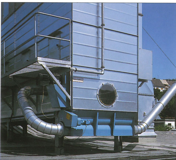
Kompaktfilter Längsbaureihe mit seitlicher Wartungsbühne
