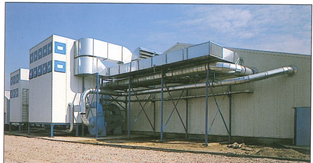
Rückluftkanalsystem mit Umlenkung und Druckentlastungsflächen
