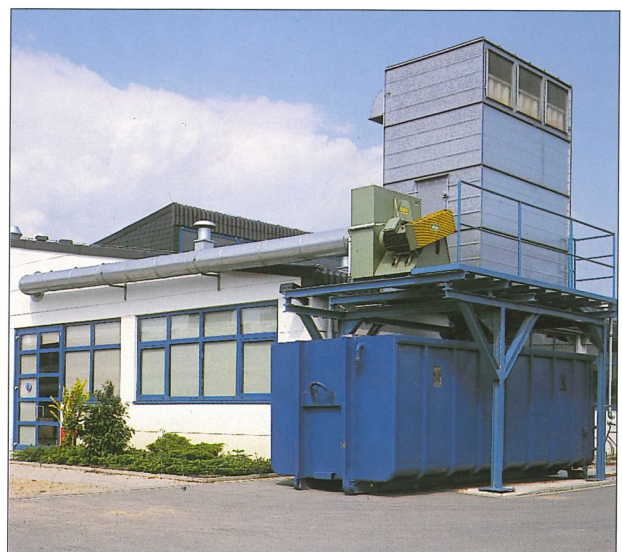
Kompaktfilter PKFQ mit Containerbeschickung
