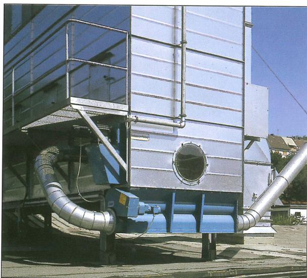
*Kompaktfilter Längsbaureihe mit seitlicher Wartungsbühne*
