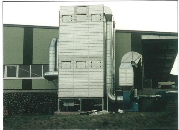
Unterdruck-Filterhaus mit Zwischenpuffer und Rührwerksaustragung
