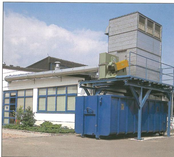
*Kompaktfilter PKFQ mit Containerbeschickung*
