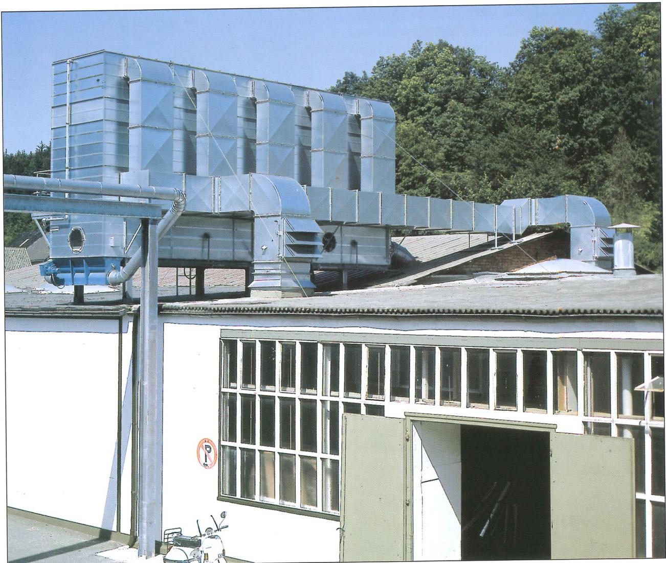
Kompaktfilteranlage PKFL 2000 mit Luftrückführung, 450 m<sup>2</sup> Filterfläche
