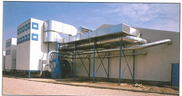
*Rückluftkanalsystem mit Umlenkung und Druckentlastungsflächen*
