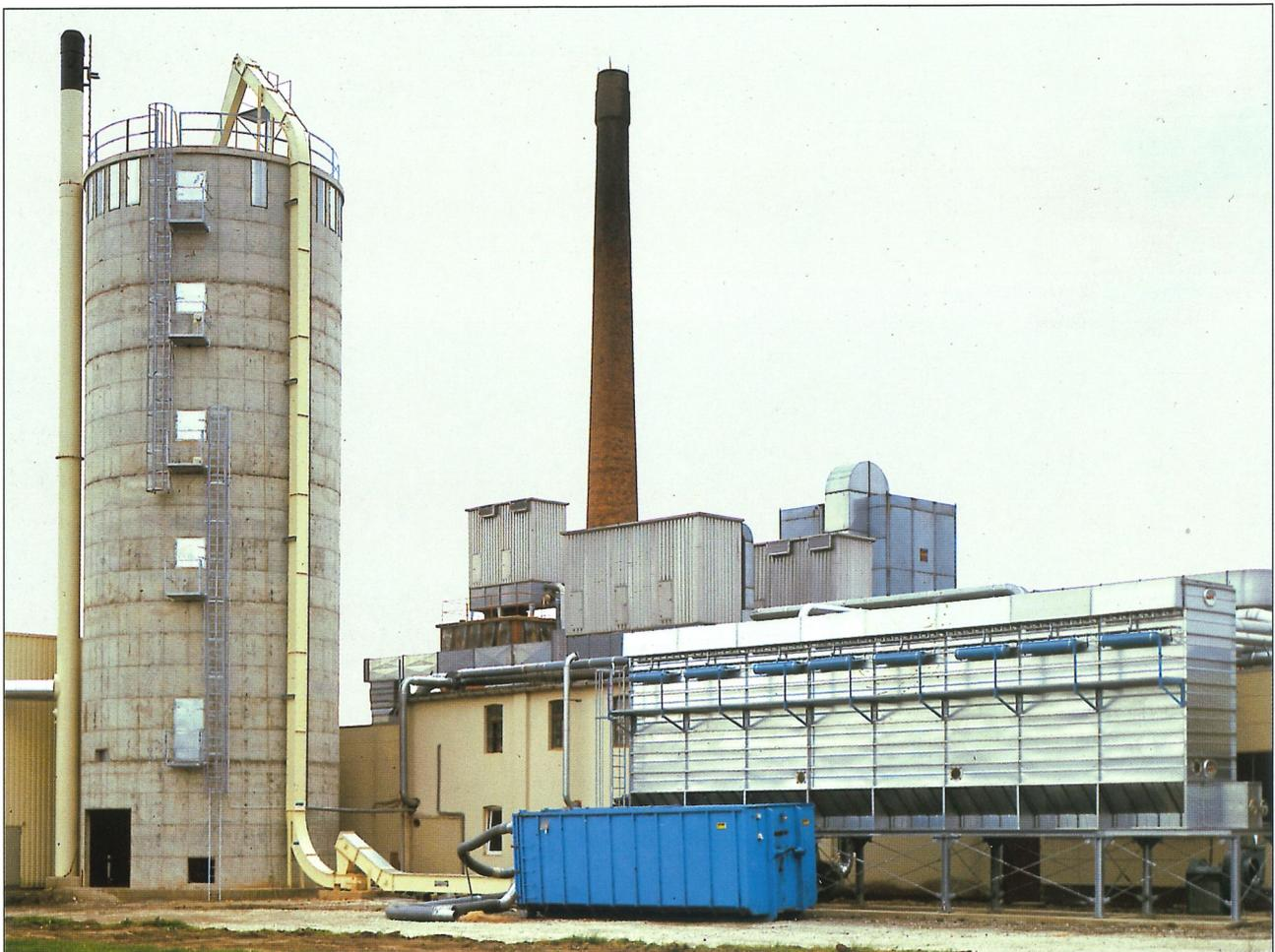
Industriefilter VacuJet, Typ PVJL 2000 mit Trogkettenförderer zur Silobeschickung, 850 m<sup>2</sup> Filterfläche
