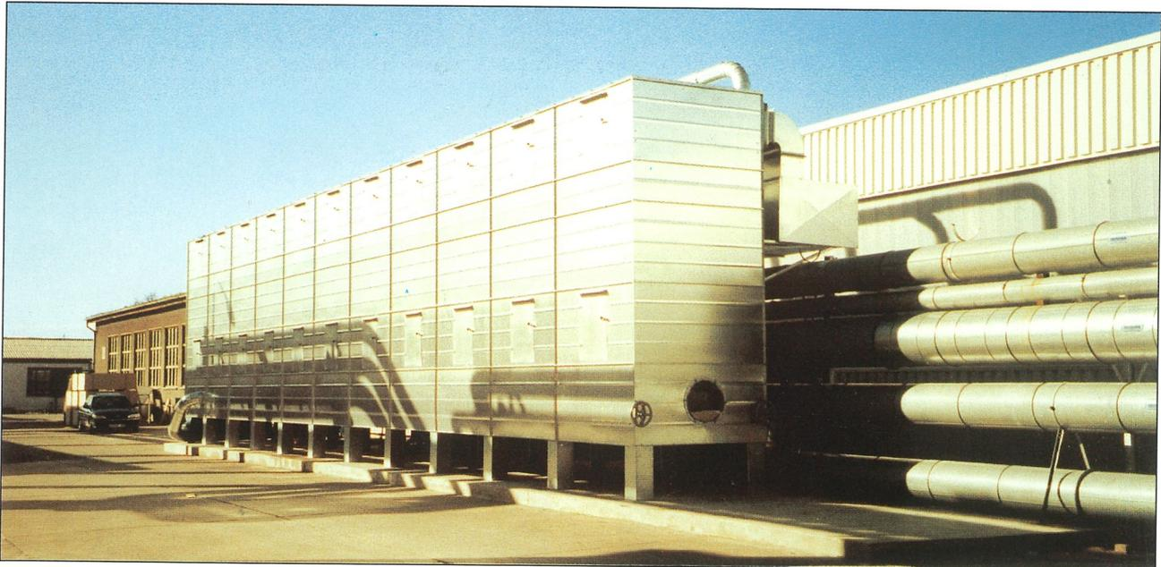
*Reihenfilter für kontinuierlichen Betrieb mit Spülluftreinigung 1.100 m<sup>2</sup> Filterfläche*
