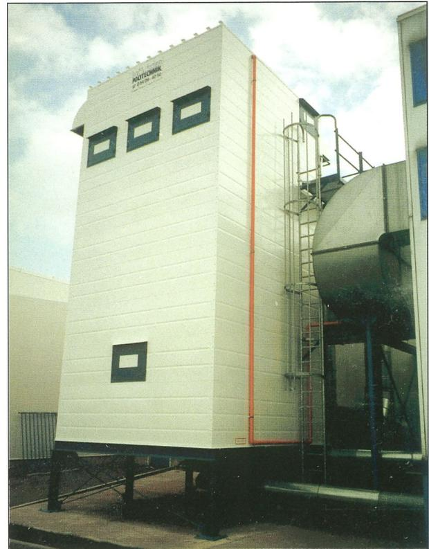
Unterdruck-Filterhaus in lackierter Ausführung
