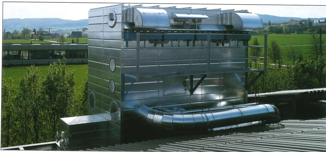
Jet-Filteranlage PVJL mit 230 m<sup>2</sup> Filterfläche; Abluftbetrieb
