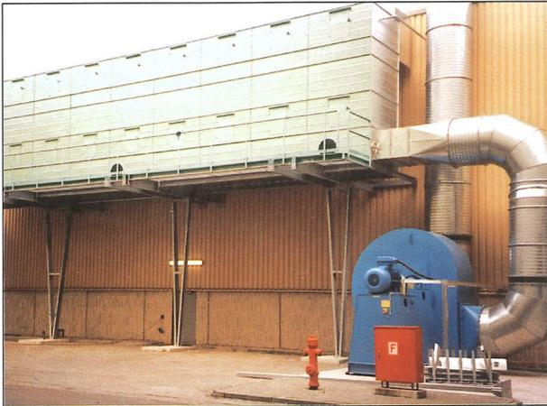
Reihenfilteranlage mit integriertem Kettenförderer
