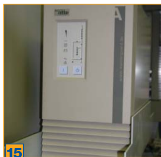
15 Onduleur pour éviter les perturbations dues aux variations de tension et la perte de données liées aux pannes de courant
