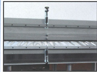
Tensionamento mylar Système tension mylar Sistema tensionado mylar
