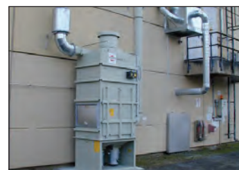
Berstscheibe zur Explosionsdruckentlastung im Freien
