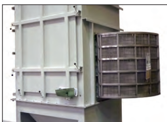
Entlastungsventil zur flammenlosen Explosionsdruckentlastung im Raum
