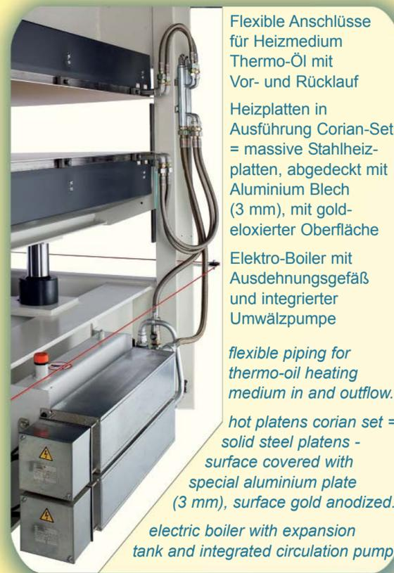
Flexible Anschlüsse für Heizmedium Thermo-Öl mit Vor- und Rücklauf
