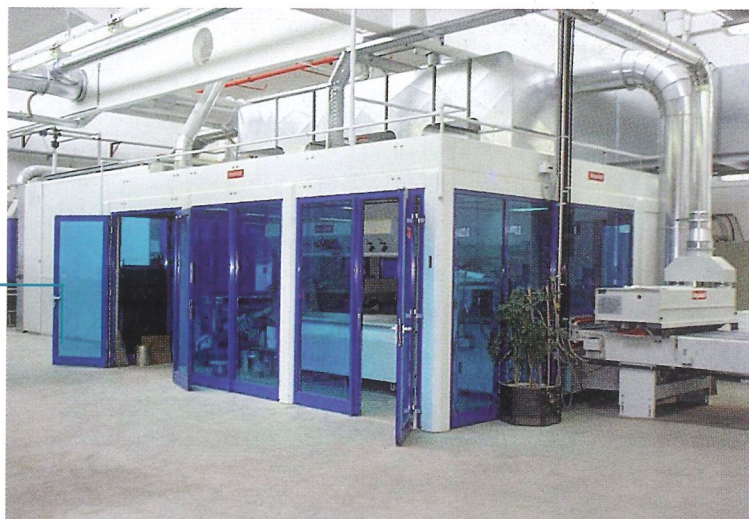
Oberflächenanlage mit Reinraum
