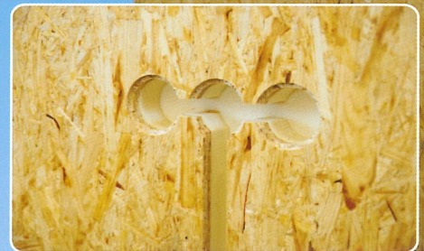
Fraisages pour installations électriques et sanitaires
