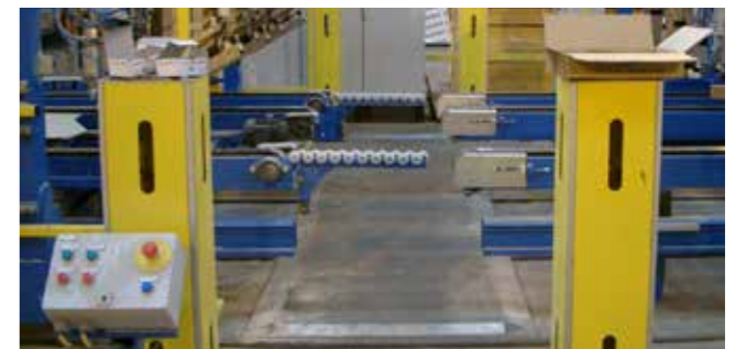
Lichtschranken und Sicherheitsschaltmatten zwischen den Stationen.
