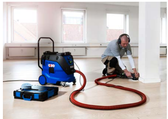
Abb. 10 Absaugung eines handgeführten Elektrowerkzeugs
