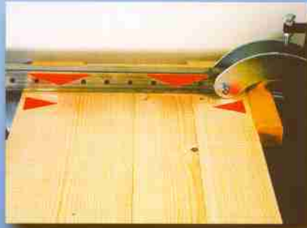
Massivholz flächenbündig verleimen
