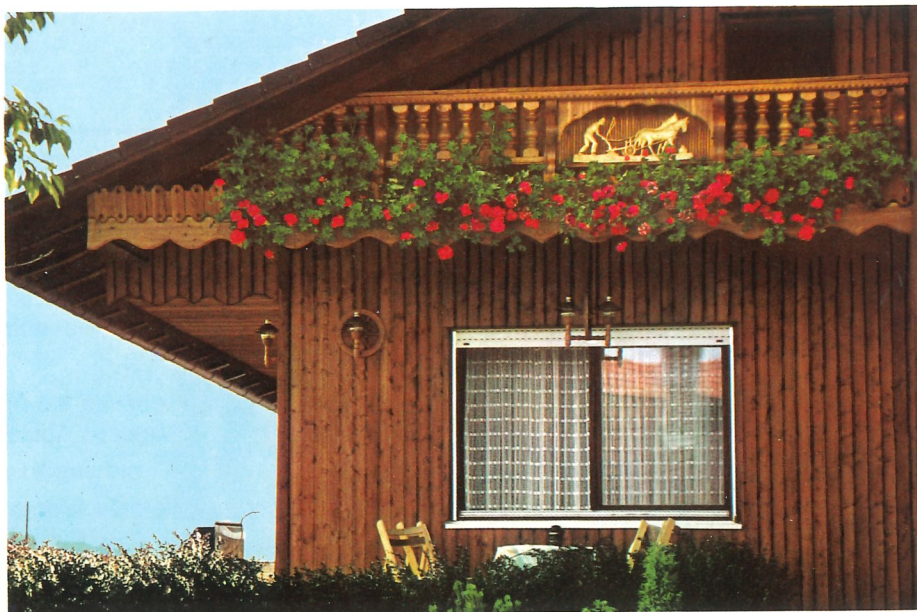
Balkonsäulen gefertigt mit einer Kopiereinrichtung KA-90.
