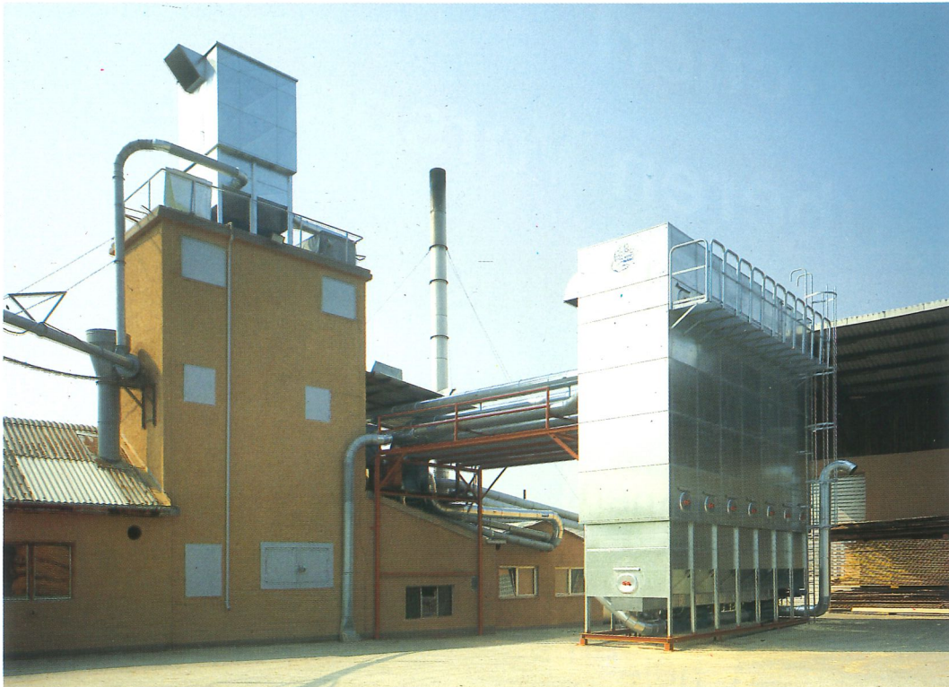
Abb. zeigt: Nestro-Gegendruckfilter mit einer Filterfläche 816 m 2 , für eine Luftmenge von 98.000 m 3 /h, ein- schließlich Transportan- lage zum Spänesilo, mit Nestro-Bunkerschleusen- filter für überdruckfreie Beschickung.
