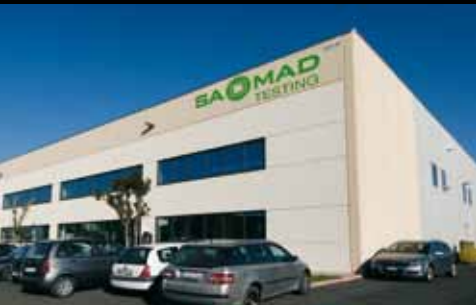
SALA COLLAUDI Testing room Prüfraum Salle des essais
