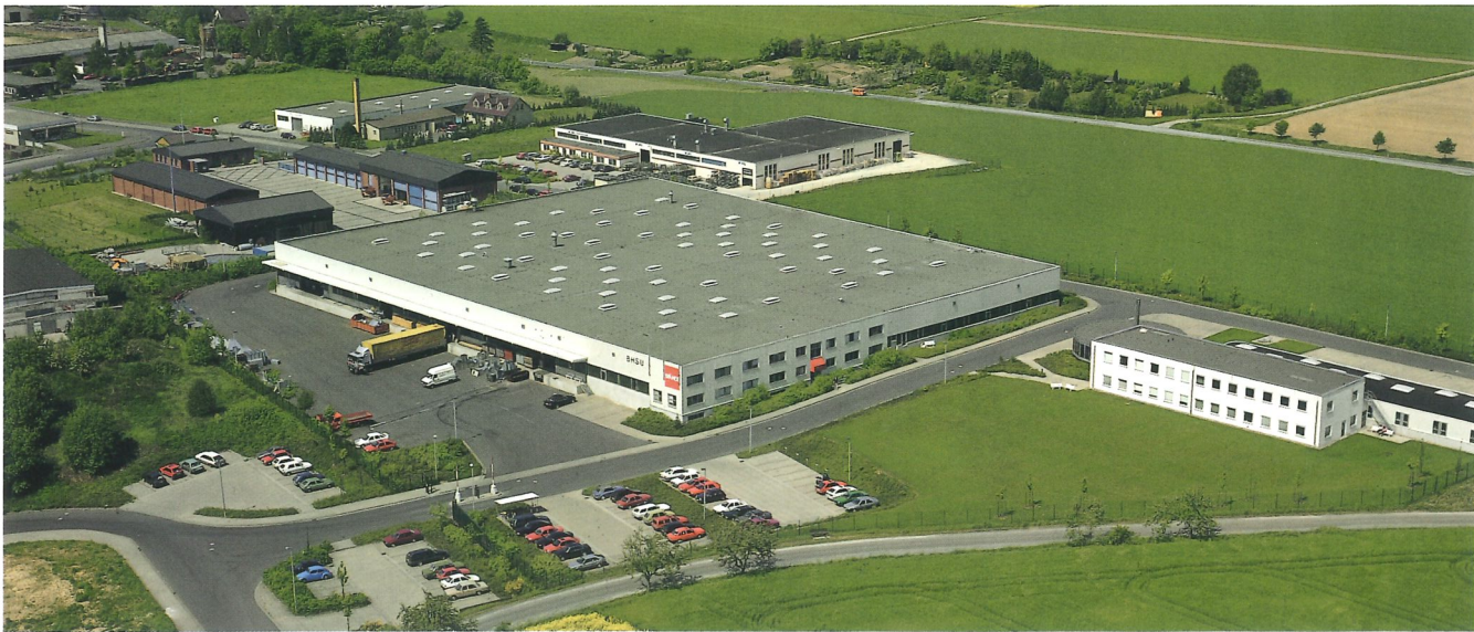
Luftaufnahme Firmengebäude SPÄNEX
