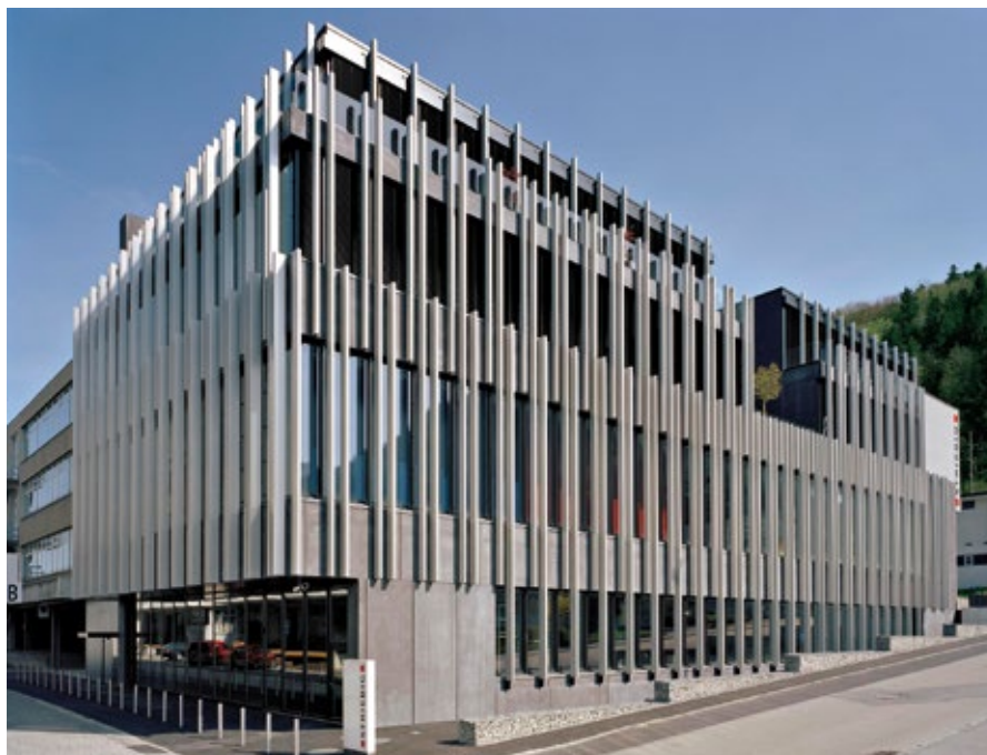
Gebaute Corporate Identity. Vertikale Aluminiumlisenen gliedern die Fassade unseres Firmensitzes in Littau bei Luzern und bilden einen guten Bezug zu unseren Produkten und Marktpartnern.
