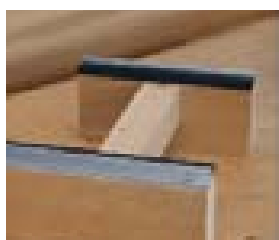
Vissage des supports de vitrage.
