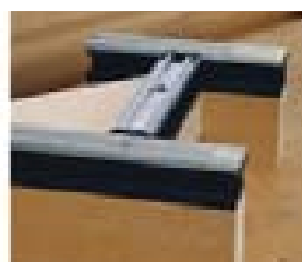
Pose du vitrage et des joints externes.
