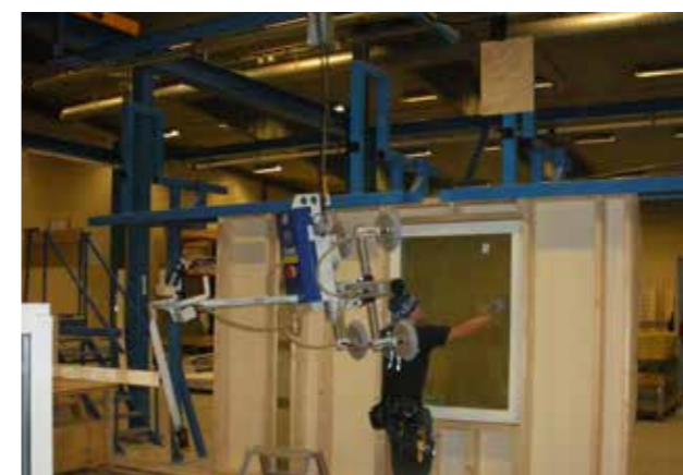
Sprawny montaż okien na wyjściowym przenośniku elementów ustawionych w pozycji pionowej.
