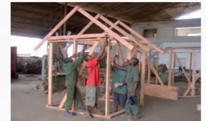
Zerstörte Häuser und verminte Felder lösten nach dem Bürgerkrieg in Angola eine Landflucht aus. Durch die von mir entwickelte Modulbauweise konnten mit einem Sägewerk pro Tag zwei Holzhäuser für die Rückkehr der Flüchtlinge gebaut werden. Die Deutsche Gesellschaft für Technische Zusammenarbeit (GTZ) und die Deutsche Botschaft hat das beeindruckt. Sieben weitere Sägewerke folgten.
