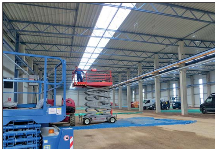
Eine neue große Halle wird zurzeit gebaut.
