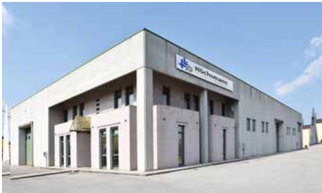
Maschinenhalle Höchsmann in Noventa di Piave (VE)
