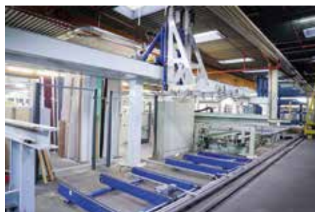
JOFO Plattenlager, Baujahr 2013
