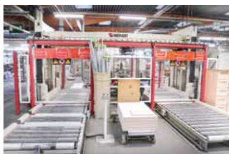
IMA MEINERT UBS4D/ST1, 1999 impianto di alimentazione ed impilamento
