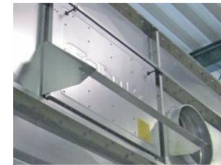
**6 Les événements d'explosion** avec déflecteur de flamme permettent une évacuation instantanée de la surpression. Le plus haut degré de sécurité est assuré par l'adjonction d'interrupteurs assurant la coupure de l'alimentation électrique générale en cas de déclenchement.
