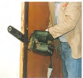
Sägen des alten Rahmens mit einer beliebigen Kettensäge bei Restaurierungsarbeiten.
