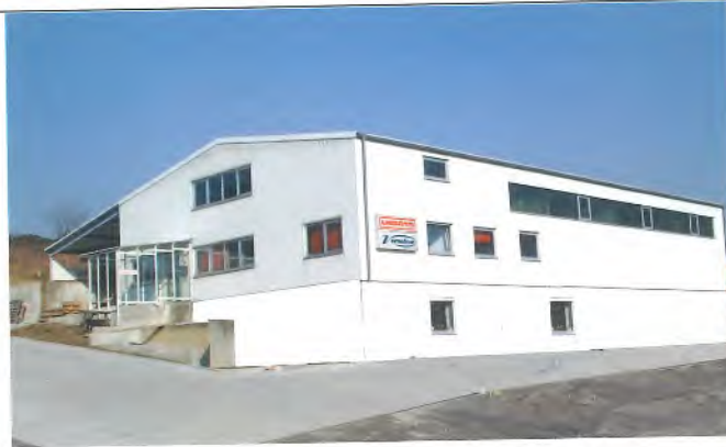
Weiß Holzmaschinen GmbH in Walzbachtal-Jöhlingen
