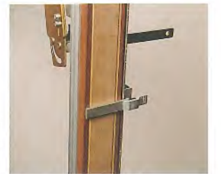
Absichern der Rahmen mit der Montagehilfe.
