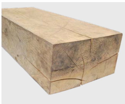
Corte seco de bloco
