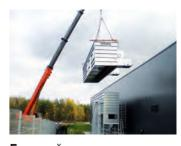
Быстрый монтаж на месте благодаря модульной системе, состоящей из отдельных блоков с индивидуальными, предварительно смонтированными элементами фильтров (Опция). Установка может быть в любое время перестроена или расширена.
